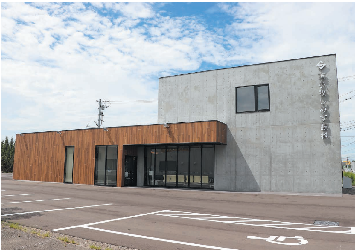
駐車場30台と十分にあり、薬局も近隣にあるため利便性が高い
