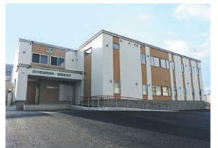
クリニック北側に透析室と個室2床を含む6床と管理棟を増設。
